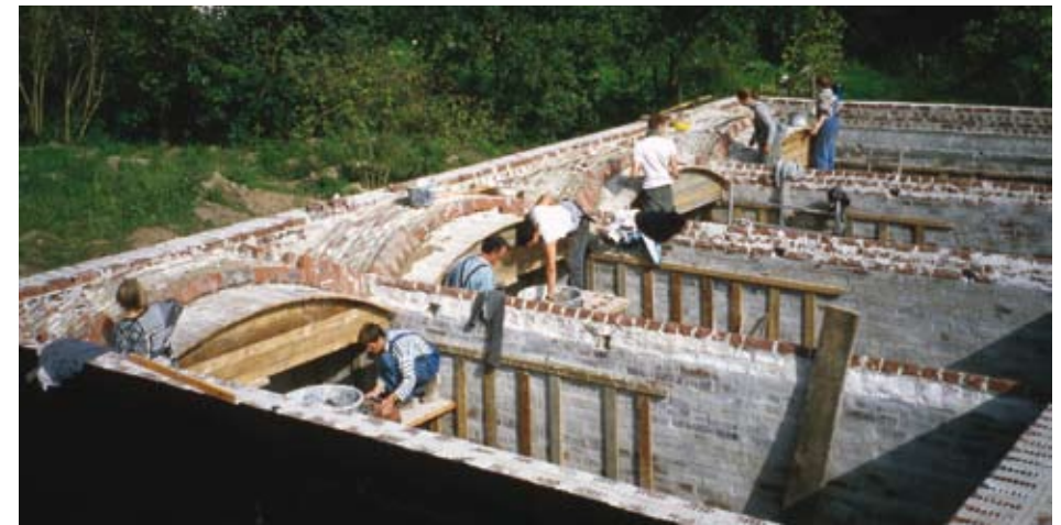
Mauern der Hamburger Kappen im Erdkeller
