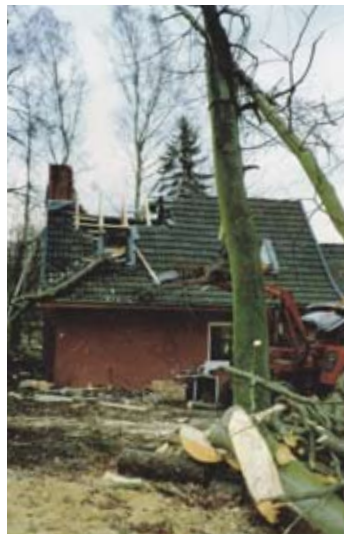
Der neue Anbau ... gleich kam ein Sturm.
