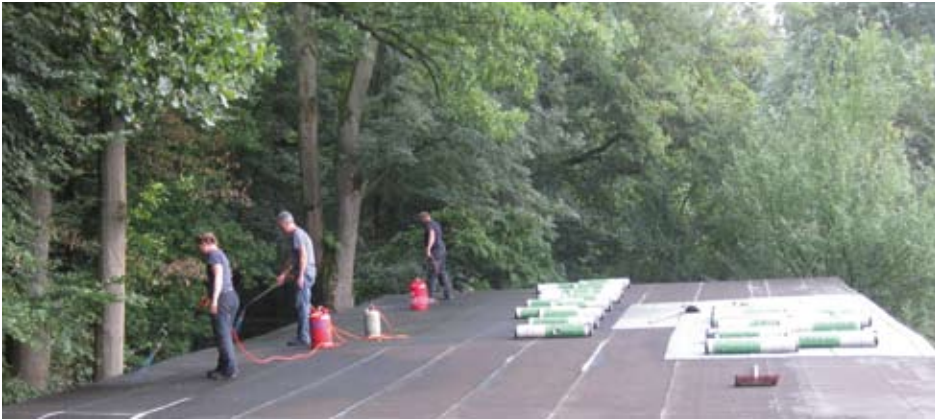
Ein neues Dach entsteht ...
