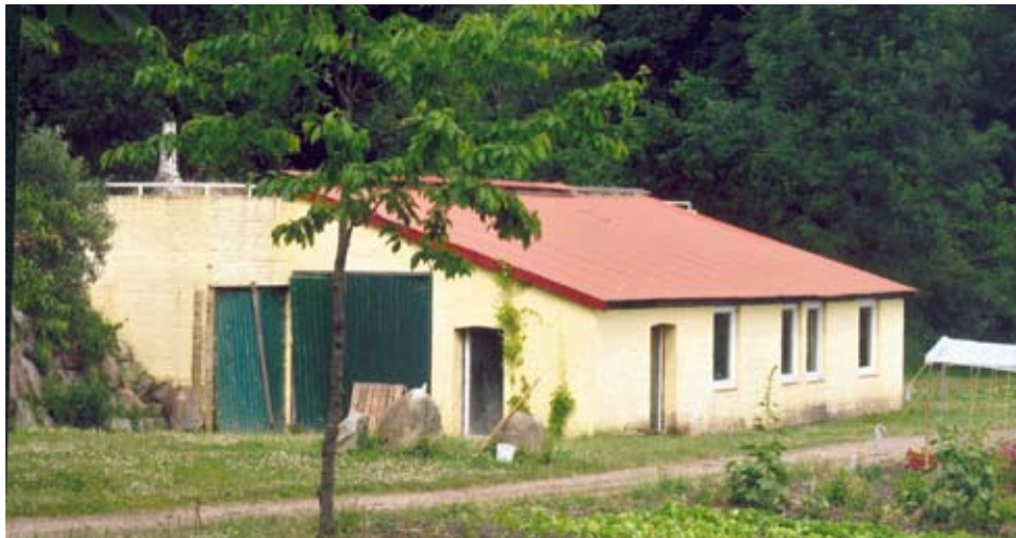
Erdkeller von Südwesten
